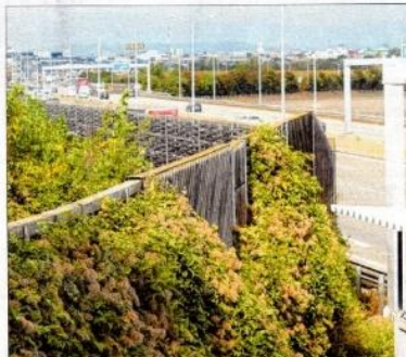
Bei über 60 Prozent aller Lärmschutz-Wände wurden gravierende Mängel festgestellt – bald wird neu gebaut.
